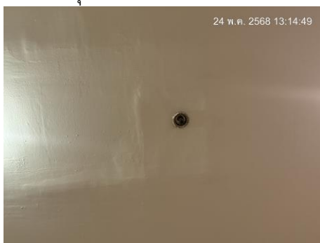
หัวกระจายน้ำดับเพลิงอัตโนมัติ รูปที่ 2.1-14 ระบบป้องกันอัคคีภัย
