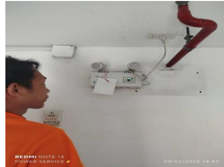
เจ้าหน้าที่ตรวจเช็คป้ายบอกทางหนีไฟ และไฟส่องสว่างฉุกเฉิน
