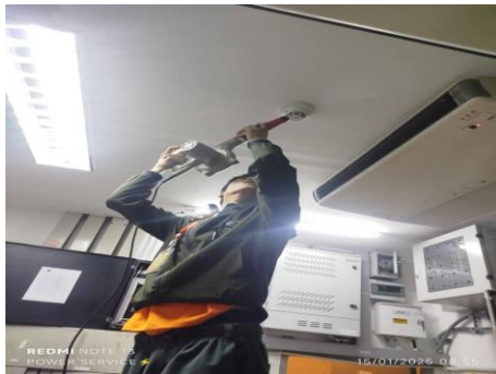
เจ้าหน้าที่ตรวจเช็คเครื่องตรวจจับความร้อน และตู้ FHC
